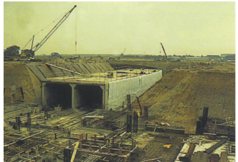
ილ. 15 გვირაბის მშენებლობა სტენსთელის აეროპორტში (ლონდონი, დიდი ბრიტანეთი). წყარო: ჰონომარიოვი ა.ბ., ვინნიკოვი ოუ.ლ. მიწისქვეშა მშენებლობა. 2014.
